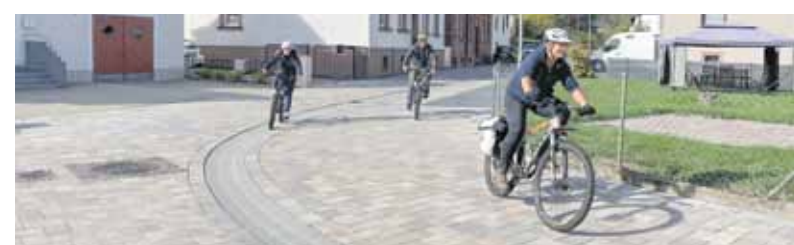
Im Sommer bietet das Pflaster den Radfahr-Touristen ideale Wege, um zur Kneipp-Anlage zu gelangen. Im Winter bleibt es frost- und tausalzbeständig – dank der EPDM-Fuge. Foto: Beton-Pfennig
