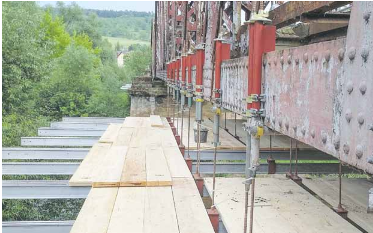
Die 1892 erbaute Carl-Alexander-Brücke über die Saale in Dornburg musste komplett saniert werden.
